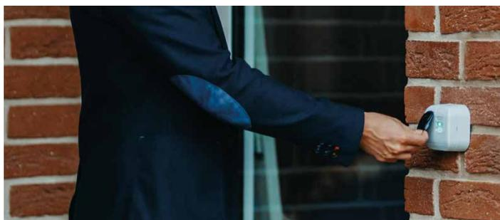
In einem weiteren Schritt folgte die Implementierung einer intelligenten Zutrittskontrolle. Heute sichert die Online- und Offline-Schließanlage proxEntry den Zugang ins Gebäude und das digitale Schließsystem doorLoxx den Zutritt zu unterschiedlichen Bereichen im Gemeindezentrum. Die ganzheitliche Lösung umfasst Zylinder, Beschläge, Schlösser, Controller und insgesamt drei Online-Lesegeräte, die an entsprechenden Knotenpunkten im Gebäude installiert sind.
